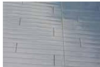
Sur lisses transversales en bois ou métalliques, dont l'espacement varie en fonction des caractéristiques du produit et des surcharges climatiques.
